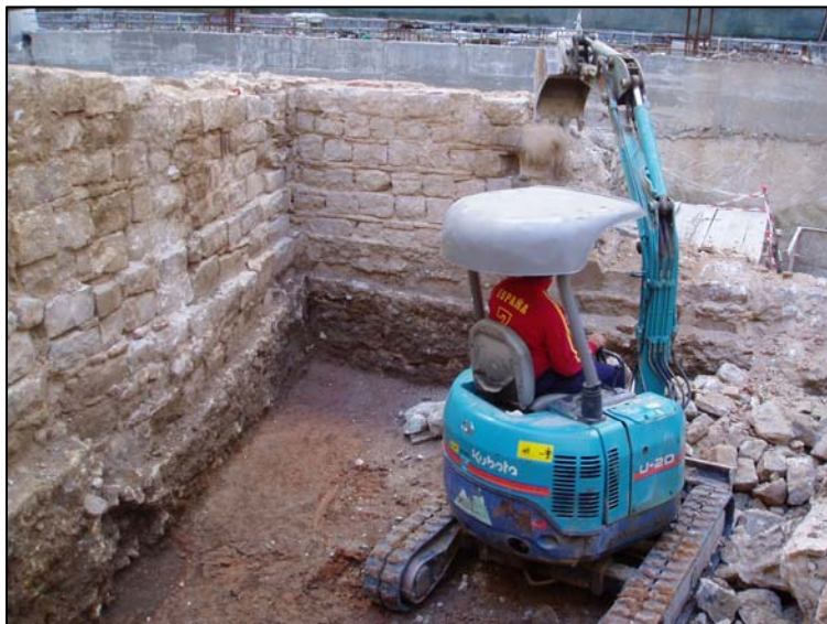
Detall de les tasques de desmuntatge controlat.
