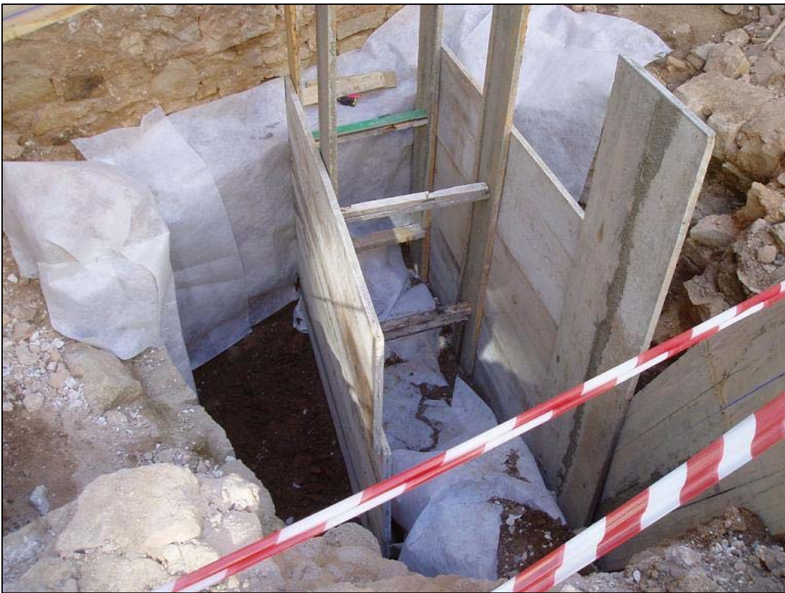
Detall del tram de mur u.e 523 conservat. També es va cobrir i conservar el pou mort u.e 503.
