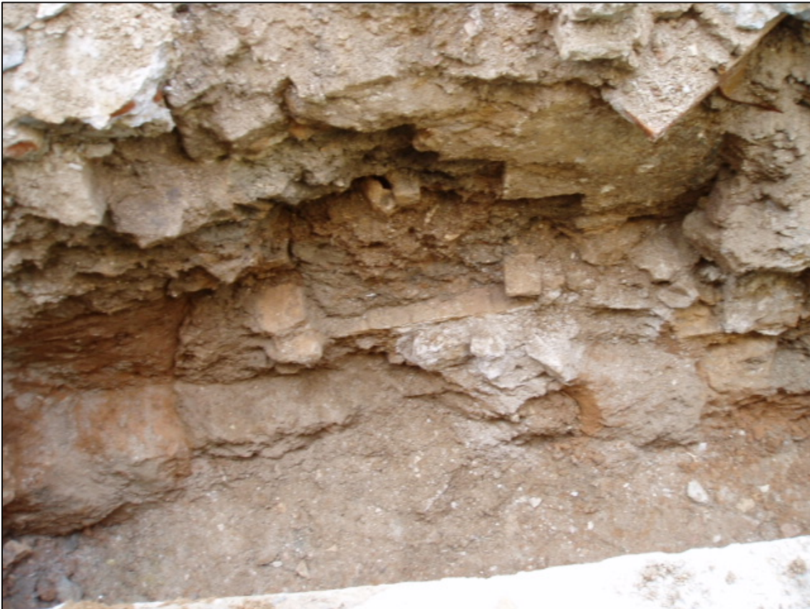
Detall de les estructures u.e 272 i 273
