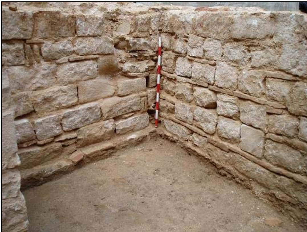
Detall del parament dels murs u.e 1307 i 1362
