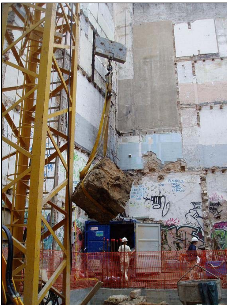
Detall del desmuntatge amb els suport de la grua. A la imatge superior aixecament de la claveguera u.e 1231. A baix una de les pilastres de fonamentació de la finca, es trasllada cap al contenidor.
