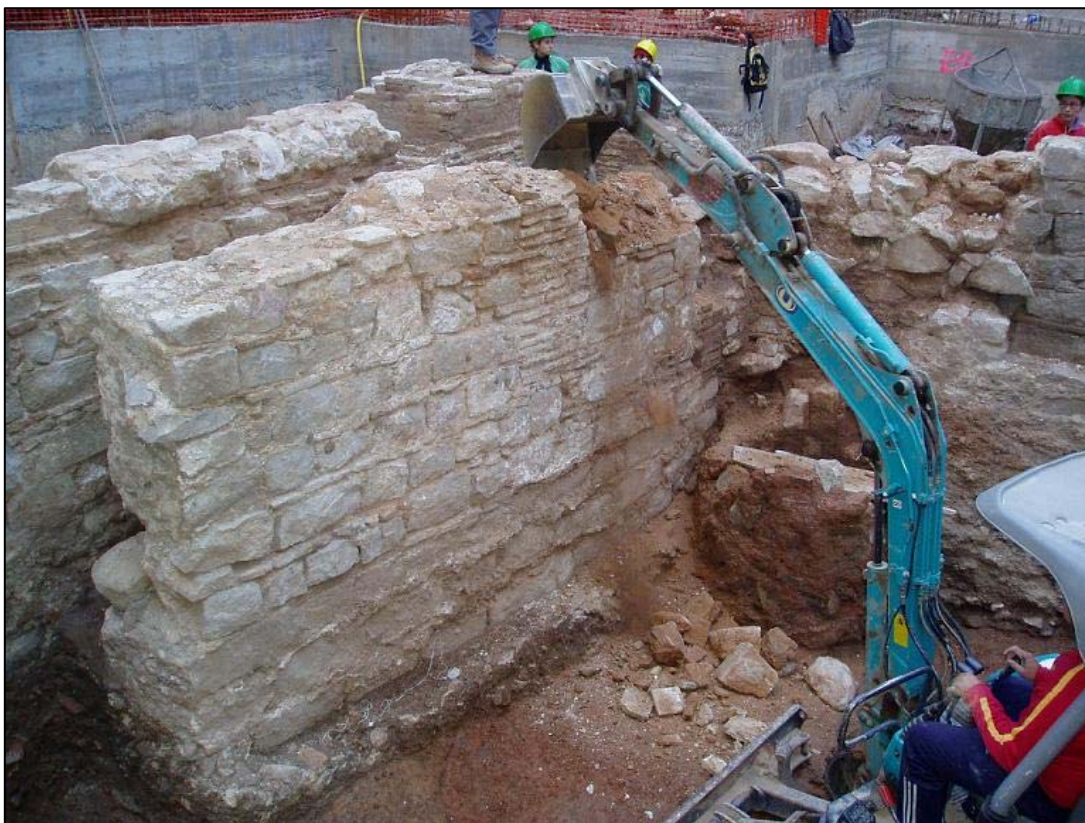
Ambdues imatges mostren diferents moments del desmuntatge d'estructures amb el suport d'una màquina.
